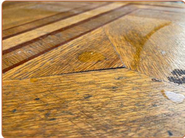
In der zweiten Phase hebt sich oft die Stelle leicht über die Oberfläche.
