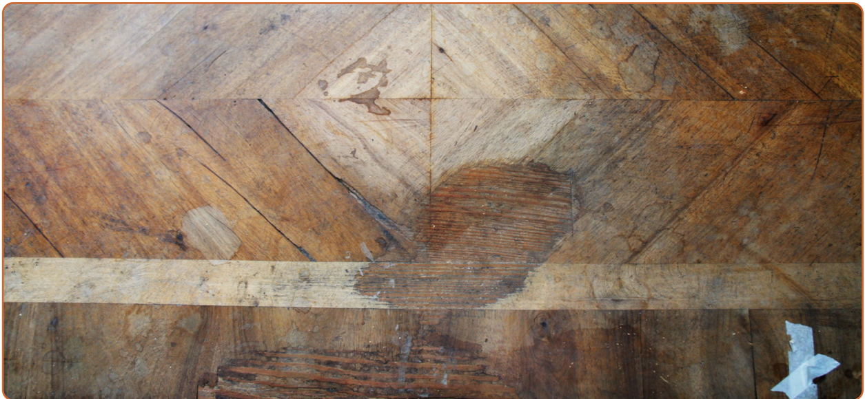
Durchgelaufene oder durchgeschliffene Furniersicht. Schloss Ludwigslust. Foto: Atelier Pucalka, Potsdam.
