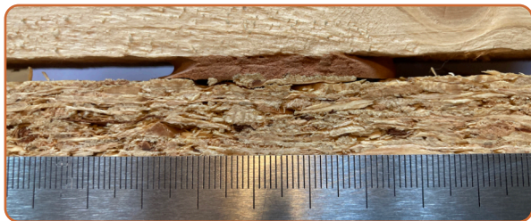
Test der Unterfüllung des Parketts mit Injektionskitt, Spaltbreite 5 mm.
