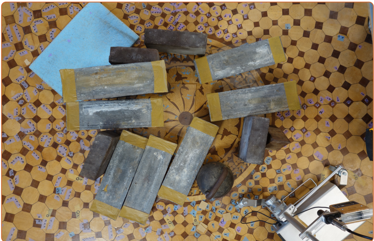
Beschwerte Stellen nach einer Injektion. In der rechten unteren Ecke ist das Steno-Injektionsgerät zu sehen. Schlossmuseum Quedlinburg.
