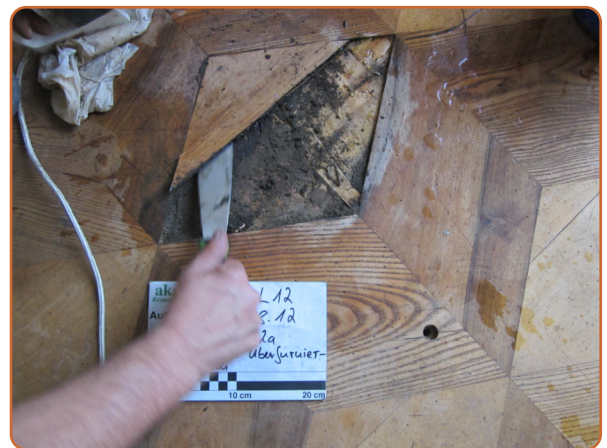
Demontage eines langfristig gelockerten Teils der Marketerie. Schloss Ludwigslust. Foto: Akanthus Restaurierungen GmbH, Eberswalde.
