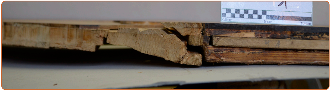
Ein gerissener Rahmenteil einer Parkettafel und in Folge dessen ein Furnierschaden. So eine Beschädigung kann durch eine mangelhafte Unterlegung der Tafel in der Laufzone kommen. Schloss Ludwigslust. Foto: Akanthus Restaurierungen GmbH, Eberswalde.
