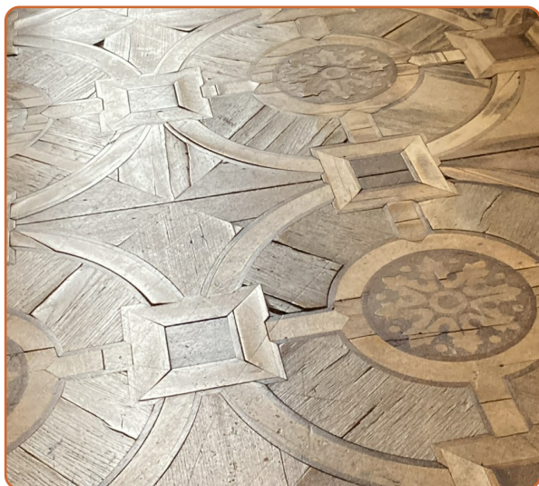
Beispiel: Parkettboden mit gelockerten und teilweise deformierten Teilen der Marketerie. Eine nicht begehbare Zone, Schloss Schwerin.
