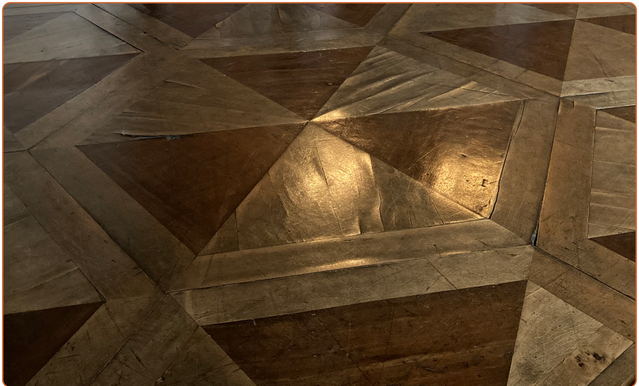
Deutlich sichtbare gelockerte Stellen im Relief des Bodens, Neues Palais Potsdam.
