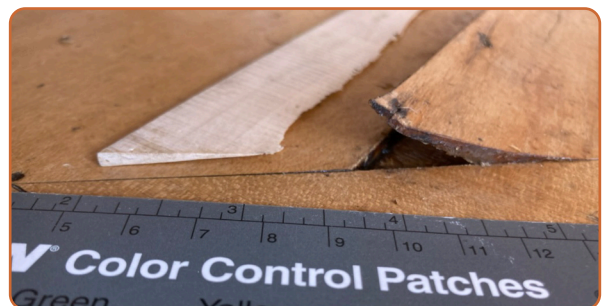
Abgeschliffenes Ahornfurnier an einer gelösten Stelle. Auf der linken Seite liegt ein vorbereiteter Unterlegkeil. Schlossmuseum Quedlinburg.
