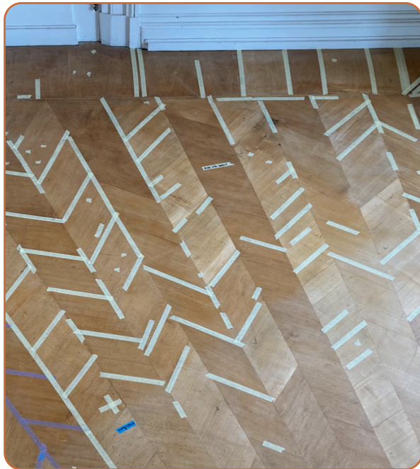
Mit einem Klebeband abgeklebte Stoßfugen zwischen den Marketerieteilen. Schlossmuseum Quedlinburg
