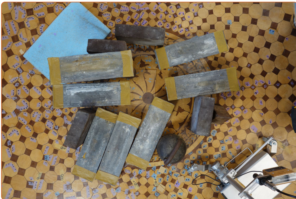
Zatížená místa po injektáži, v pravém dolním rohu je vidět steno-injekční zařízení, Zámecké muzeum, Quedlinburg.
