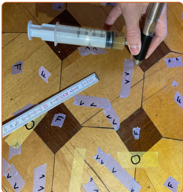
Injektáž podlahy, Zámecké muzeum Quedlinburg UNESCO
