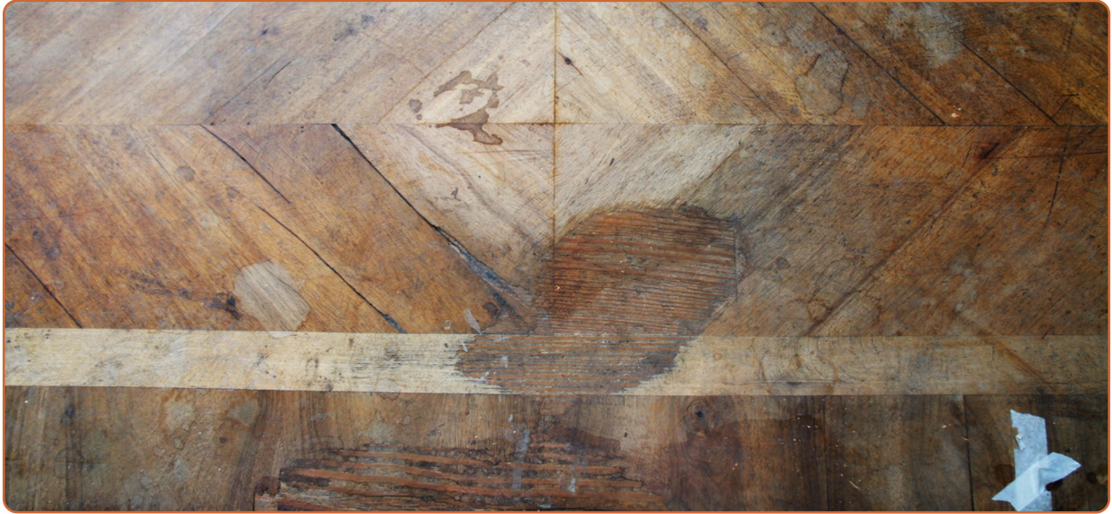
Prošlápaná nebo probrpoušená nášlapná dýhová vrstva. Zámek Ludwigslust, Foto: Atelier Pucalka, Postupim
