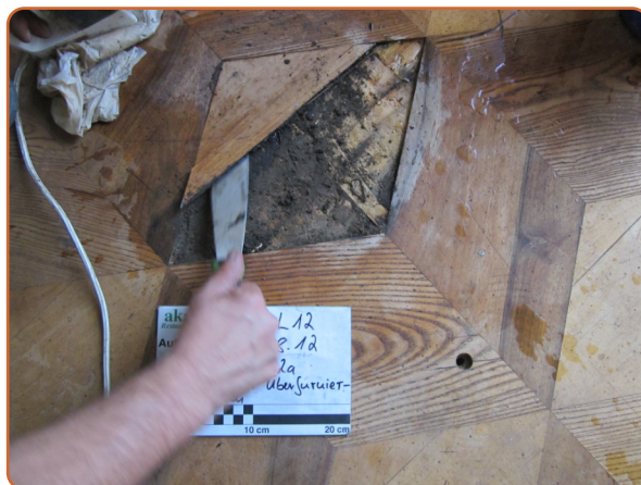
Demontáž dlouhodobě uvolněné části intarzie. Zámek Ludwigslust, Foto: Akanthus Restaurierungen GmbH, Eberswalde
