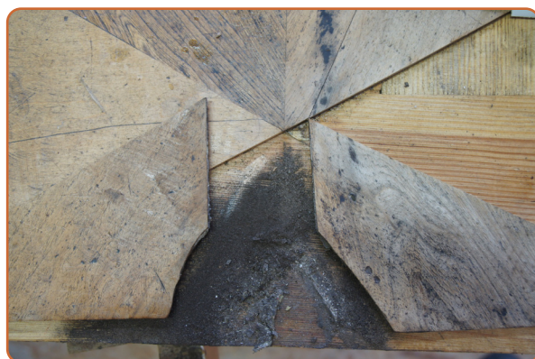
Odtržené části intarzie na dlouhodobě zanedbaném místě s velmi silnou vrstvou nečistot pod dýhou. Zámek Ludwigslust, Foto: Atelier Pucalka, Postupim
