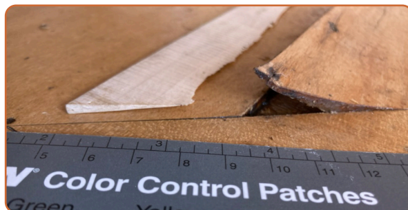
Ztenčená javorová dýha na dlouhodobě zanedbaném místě. Na levé straně leží připravený podkladový klín. Zámecké museum Quedlinburg
