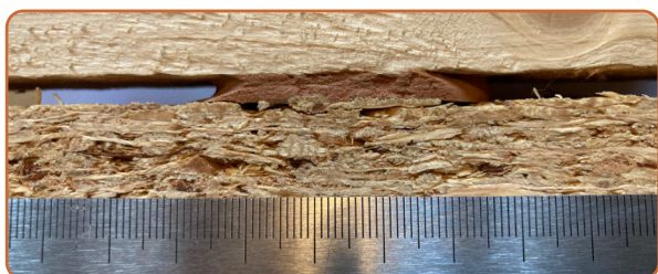
Zkouška podložení parkety injekčním tmelem. Šířka spáry 5 mm.
