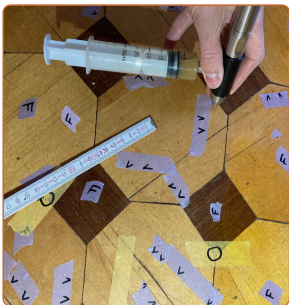
Injektáž podlahy, Zámecké muzeum Quedlinburg UNESCO
