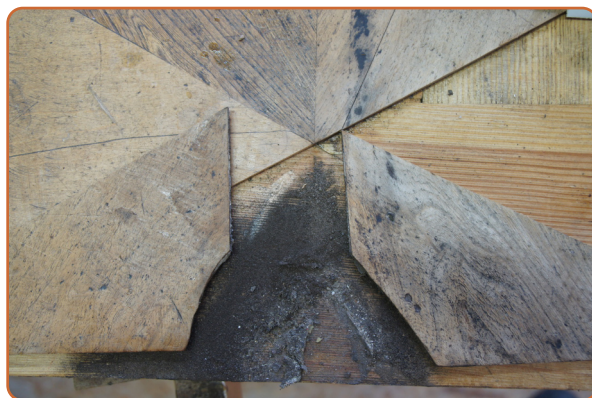
Održené části intarzie na dlouhodobě zanedbaném místě s velmi silnou vrstvou nečistot pod dýhou. Zámek Ludwigslust, Foto: Atelier Pucalka, Postupim
