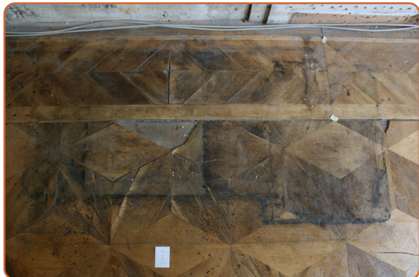
Dlouhodobě zanedbaná podlaha. Části intarzie chybí nebo odstávají tak vysoko, že bezprostředně hrozí jejich odlomení a ztráta. Zámek Ludwigslust. Foto: Atelier Pucalka, Postupim
