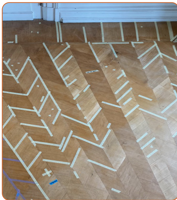
Páskou přelepené uvolněné spáry mezi díly marketerie, Zámecké muzeum, Quedlinburg.
