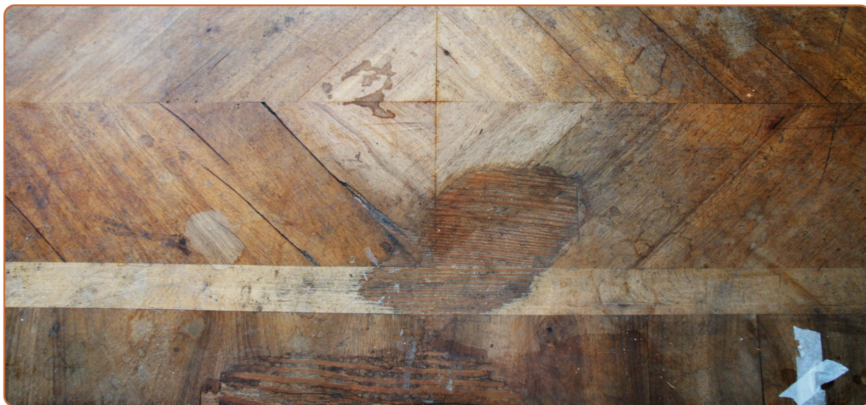
Prošlapaná nebo probrpoušená nášlapná dýhová vrstva. Zámek Ludwigslust, Foto: Atelier Pucalka, Postupim
