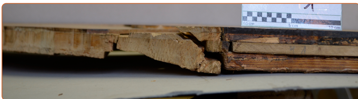
Roztržený rám parkety a poškozená intarzie. Takové poškození může být způsobeno nedostatečným podložním parkety v namáhané zóně. Zámek Ludwigslust. Foto: Akanthus Restaurierungen GmbH, Eberswalde.
