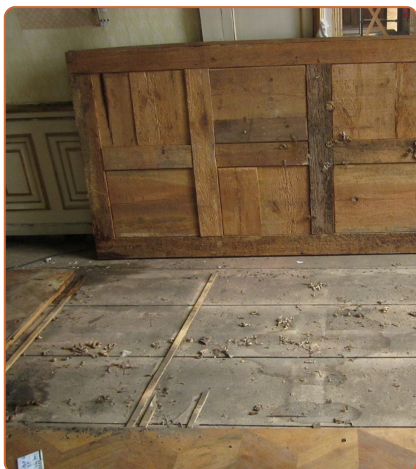
Zvednutá parketa, pod kterou se nacházejí původní podkladové lišty a prkenná podlaha. Původní situace. Zámek Ludwigslust. Foto: Akanthus Restaurierungen GmbH, Eberswalde.
